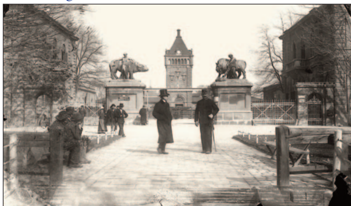
Schlachtbrücke 1903 Deutsche Fotothek, Foto: Brück und Sohn
